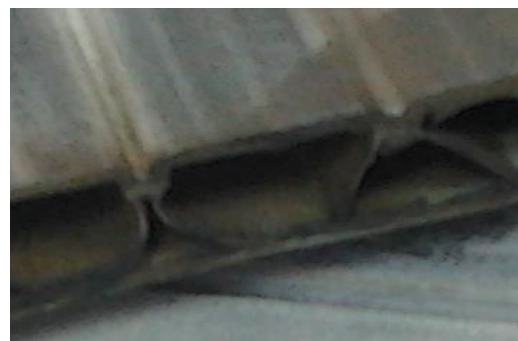
Возникновение утяжины в конструкции панели
